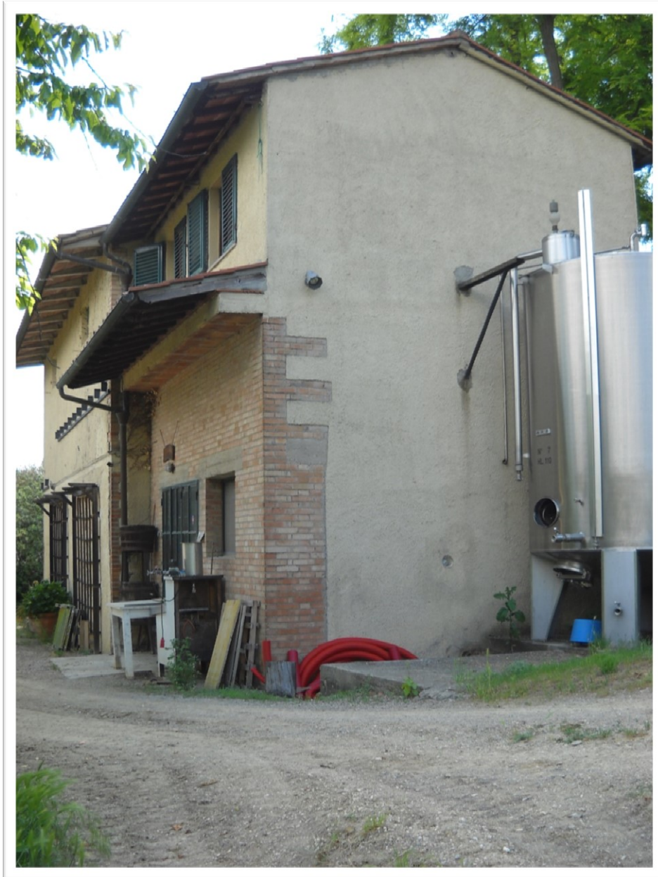
Foto 3- fabbricato “B” (da demolire)
